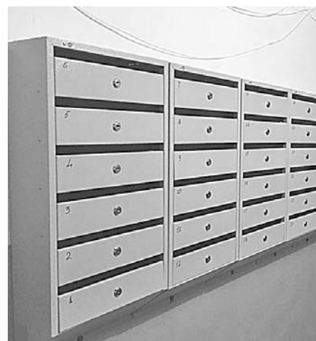
Замена почтовых ящиков, ул. Белинского, 53
