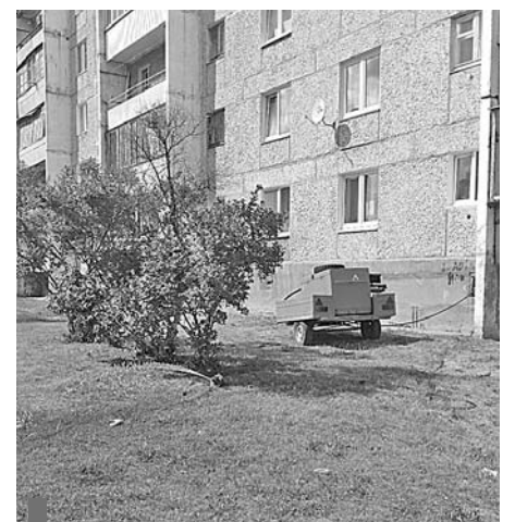
Опрессовка системы отопления, ул. Пушкинская, 4/2
