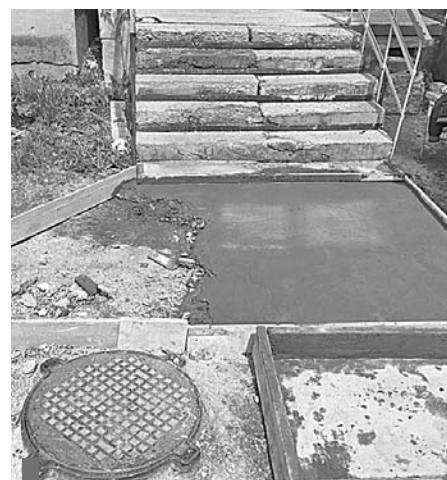
Ремонт крыльца, ул. Гоголя, 15
