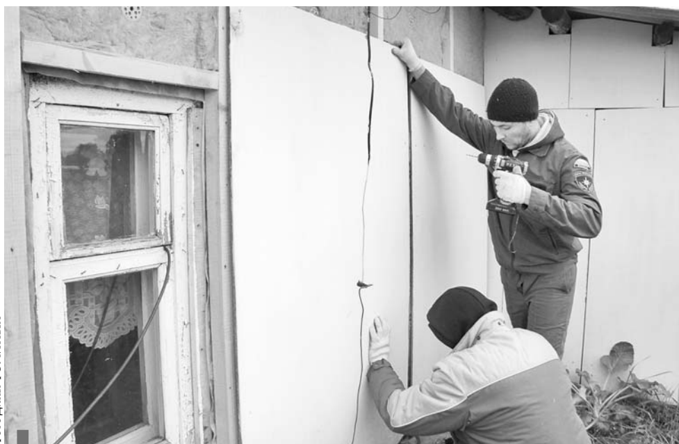
Последние штрихи – облицовочный материал
