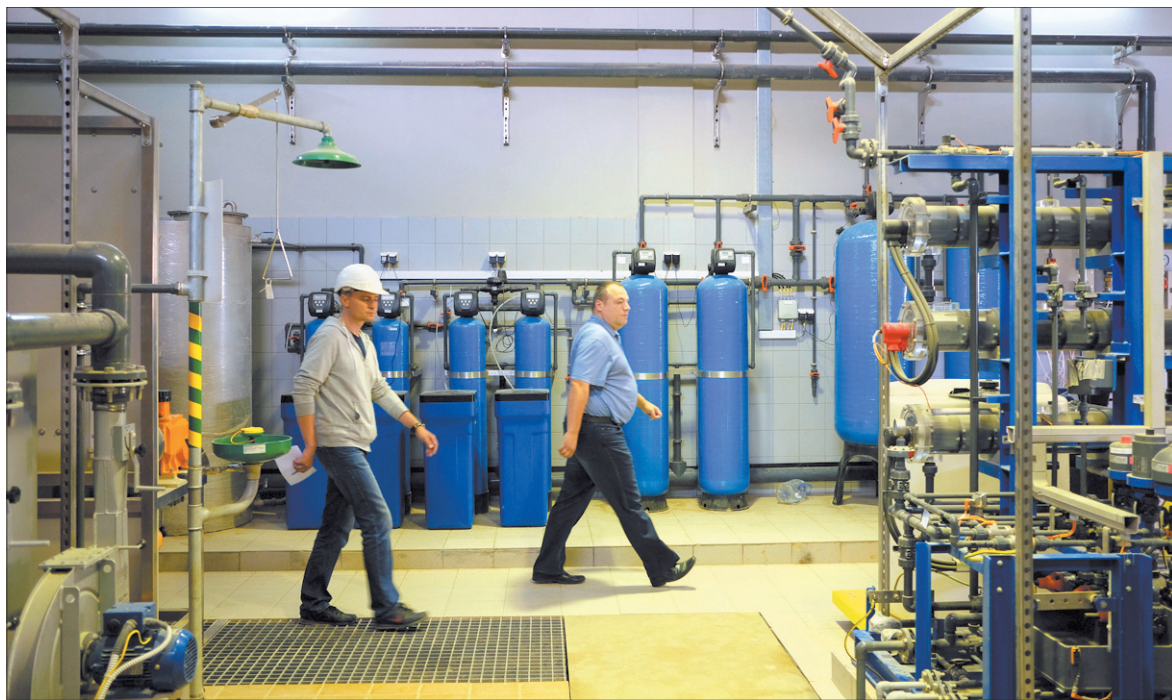
Цех обеззараживания: гипохлорит натрия выделяют из поваренной соли на аппаратах гидролиза.
