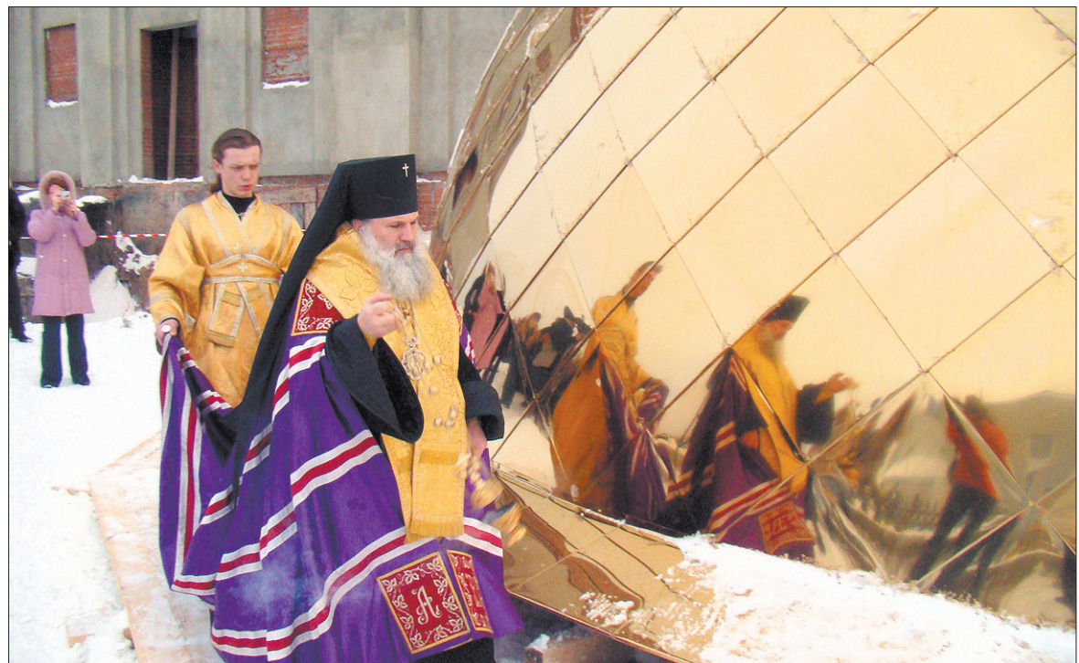
2008 год. 14 марта на здание строящейся церкви во имя Архистратига Михаила были установлены купол и крест.
