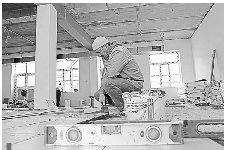
Ремонтные работы в помещении школьной столовой
