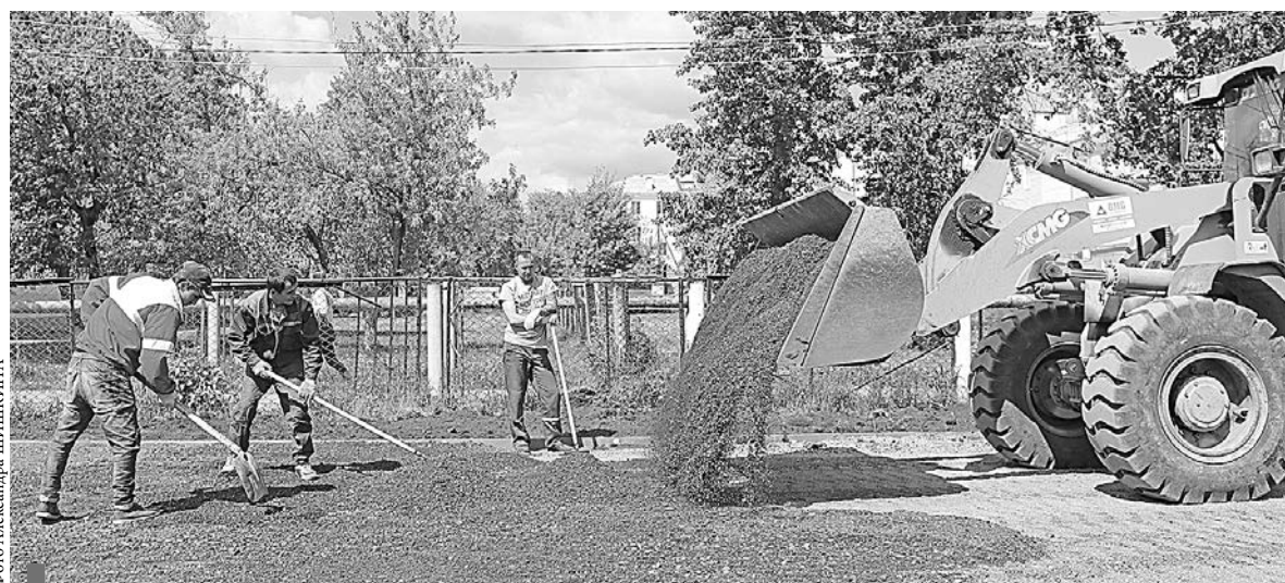
Обустройство спортивной площадки
