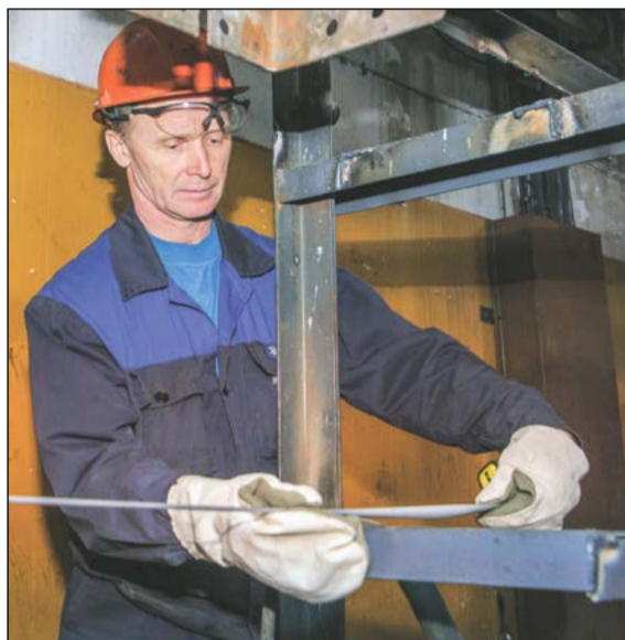
Электромонтёр Сергей Гаврютин делает замеры под будущие шины
