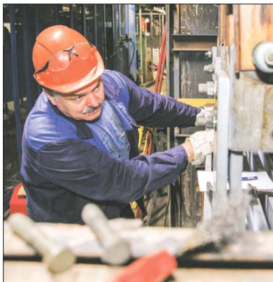
Электромонтёр Игорь Самойленко монтирует шины на разъединителе
