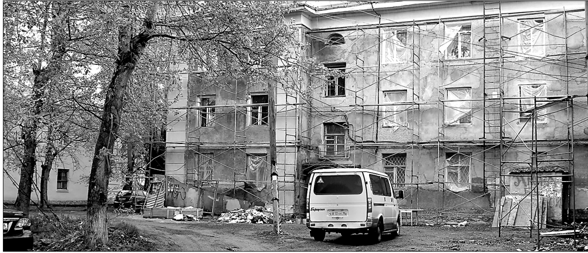
На Карла Маркса, 8, восстанавливается эстетический облик здания
