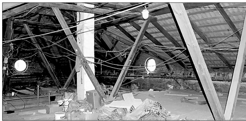
На крыше проводятся работы по усилению балок
