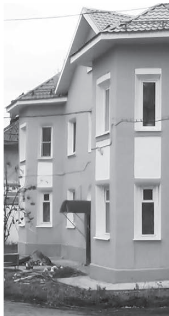
На ул. Ватутина. ФОТО АВТОРА
