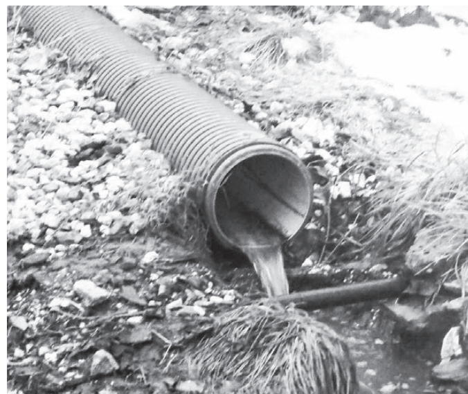
С помощью дренажных труб владельцы участков пытаются отвести воду от своих домов
