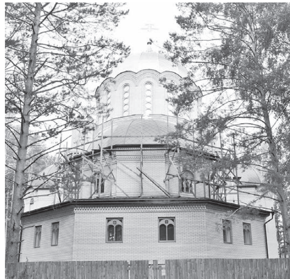
Идет строительство нового храма. ФОТО АВТОРА
