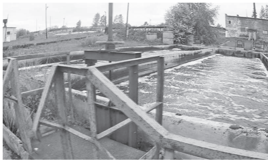
Отстойник очистных сооружений г. Лесного. ФОТО АВТОРА
