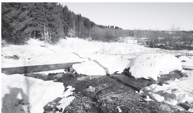
С улицы Щорса до сих пор канализационные воды стекают в огороды. ФОТО АВТОРА
