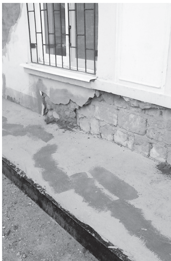
Нижний Тагил, ул. Тимирязева, д. 42, после капремонта. ФОТО ИЗ СЕТИ ИНТЕРНЕТ
