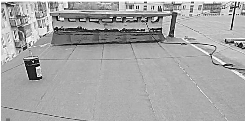
Ремонт кровли дома №1 по переулку Буденного
