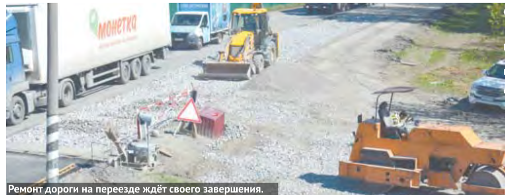
Ремонт дороги на переезде ждёт своего завершения.
