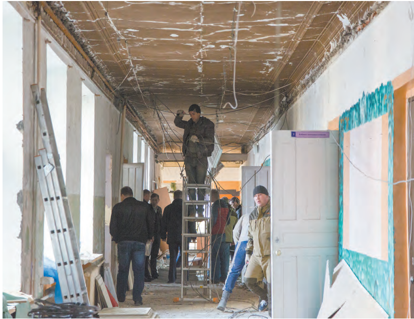
На объекте трудятся 60 работников.
