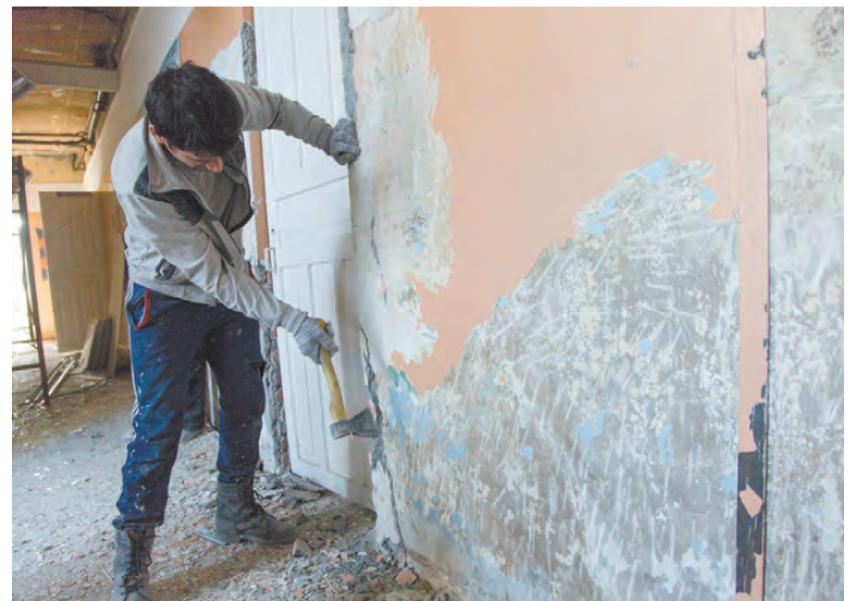
Со стен снимают штукатурку.
