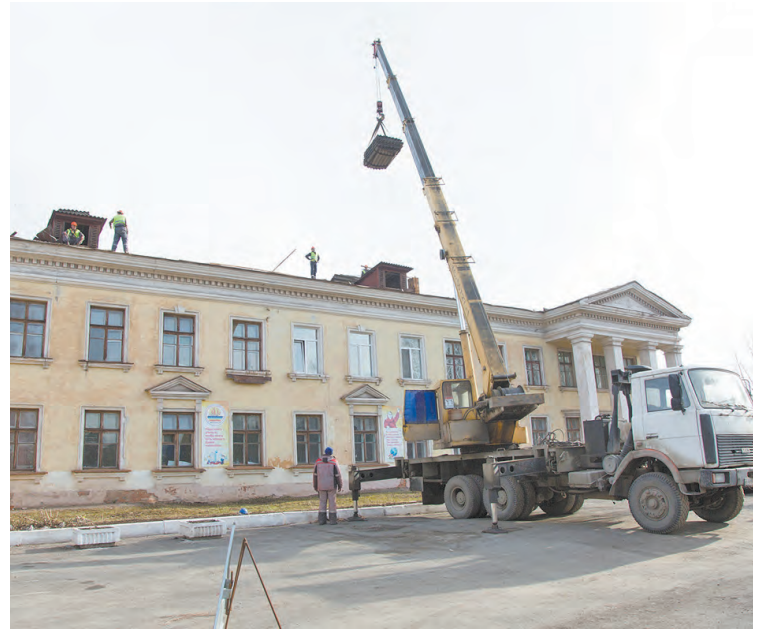
Демонтаж кровли.
