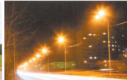
Ул. Алтайская. Наружное освещение. Было/стало.
