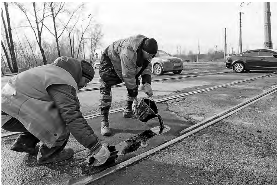
Ямочный ремонт на трамвайных путях. ФОТО СЕРГЕЯ КАЗАНЦЕВА.
