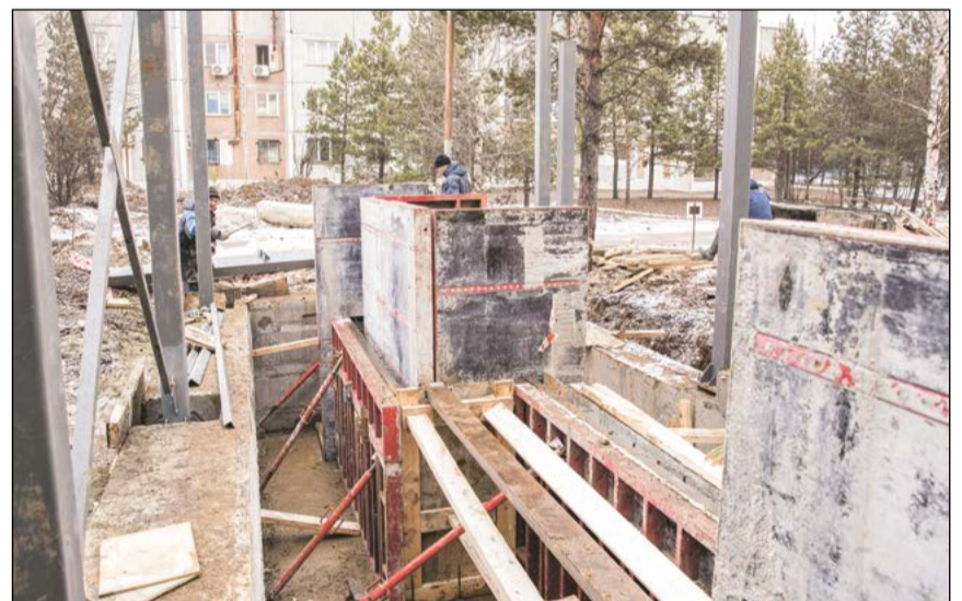
Фундамент для трансформаторной подстанции готов
