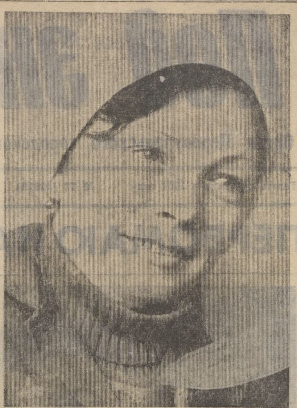
В. Л. Самылова строит больничный комплекс динасового завода. Она штукатур-маляр из бригады Т. Д. Медведевой, которая в первом управлении треста Уралтяжтрубстрой одна из лучших. Валентина Леонидовна — коммунист, передовая труженица.
