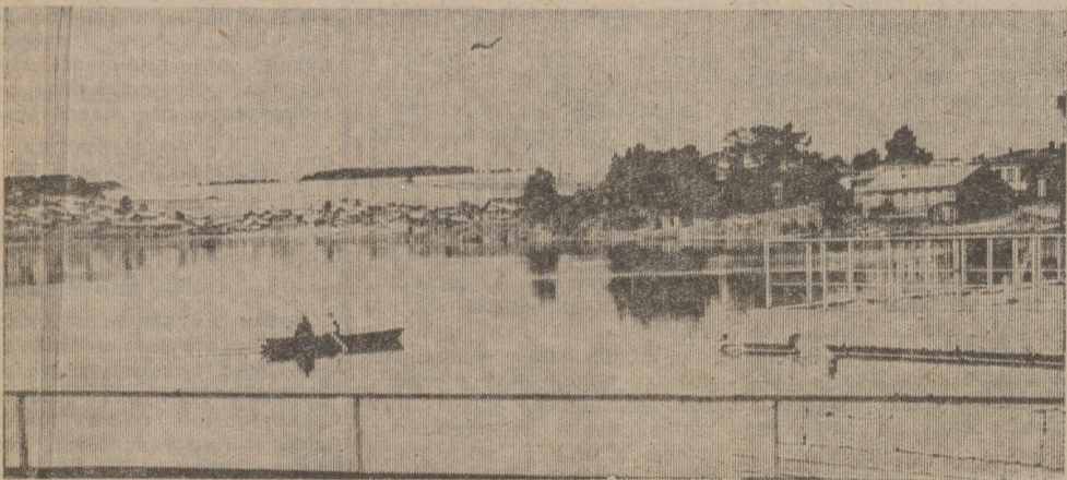
Поселок Новотрубинск. Вид с плотины.
