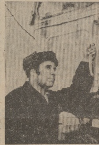
ВОДОВОД НИЖНИЕ СЕРГИ — ПЕРВОУРАЛЬСК — ПУСКОВОЙ ОБЪЕКТ
