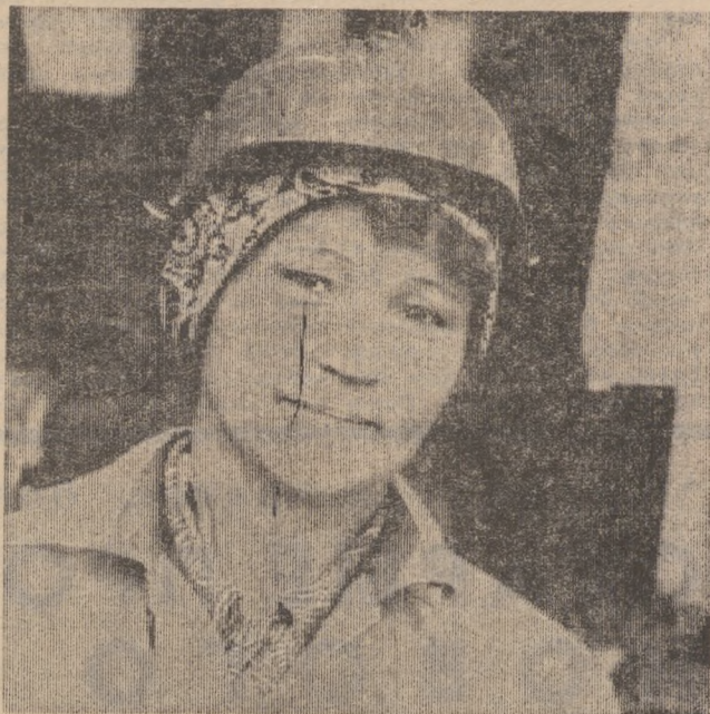
Ударно трудится на возведении комплекса туннельной печи динасового завода электросварщика второго стройуправления З. Н. Муланурова. Строит она этот комплекс с самого первого дня.
