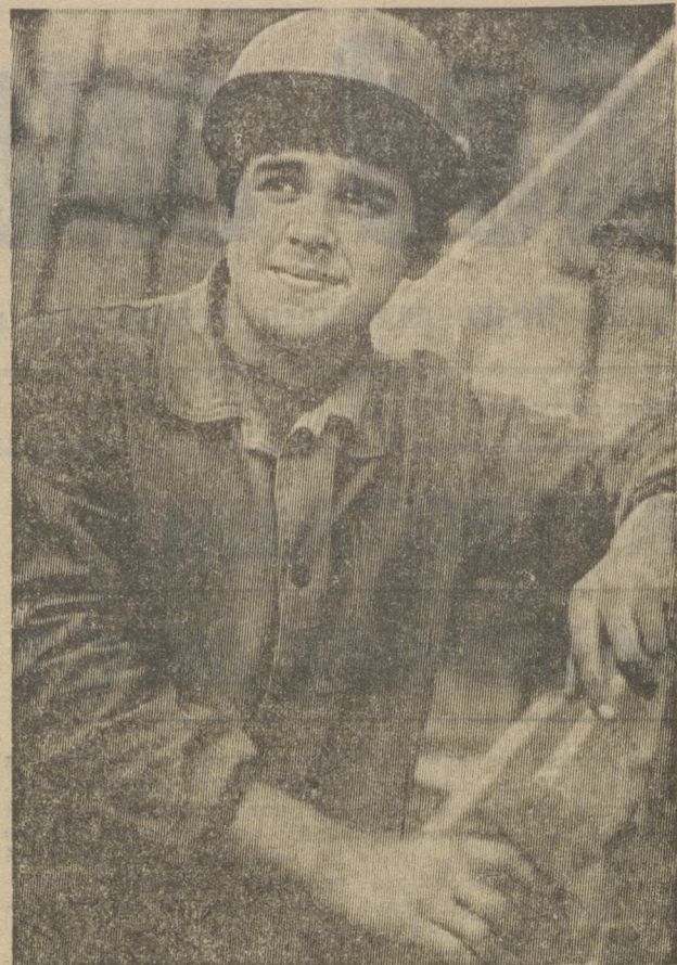
Бригада Т. Г. Чекуба из первого управления треста Уралтяжтрубстрой ведет основные работы на плавательном бассейне — кирпичную кладку. Каждый каменщик кладет в смену почти по два кубометра, выполняя норму на 165 процентов. Сам бригадир квалифицированный, грамотный рабочий. У него хороший помощник А. Н. Рябов, в любое время Анатолий Николаевич может подменить бригадира. Комсомолец Альберт Рахманов второй год работает в бригаде плотником. Строительную закалку получает на пусковом объекте.
