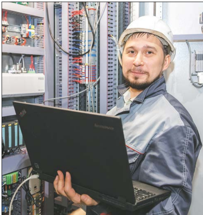
Алексей Мещеряков должен поставить «точный диагноз» трансформатору
