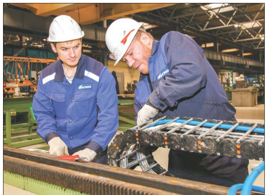
Специалисты цеха № 24 Александр Ермигин и Игорь Беляев принимают активное участие в монтаже электрической части линии
