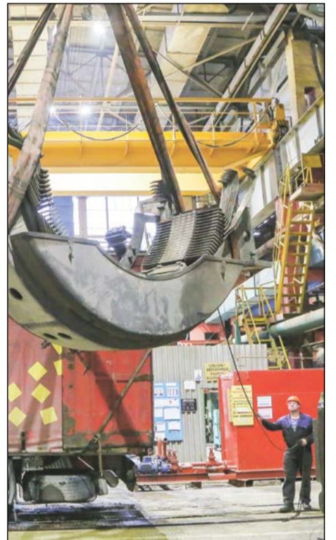
Из машинного зала вывозят элемент старого оборудования
