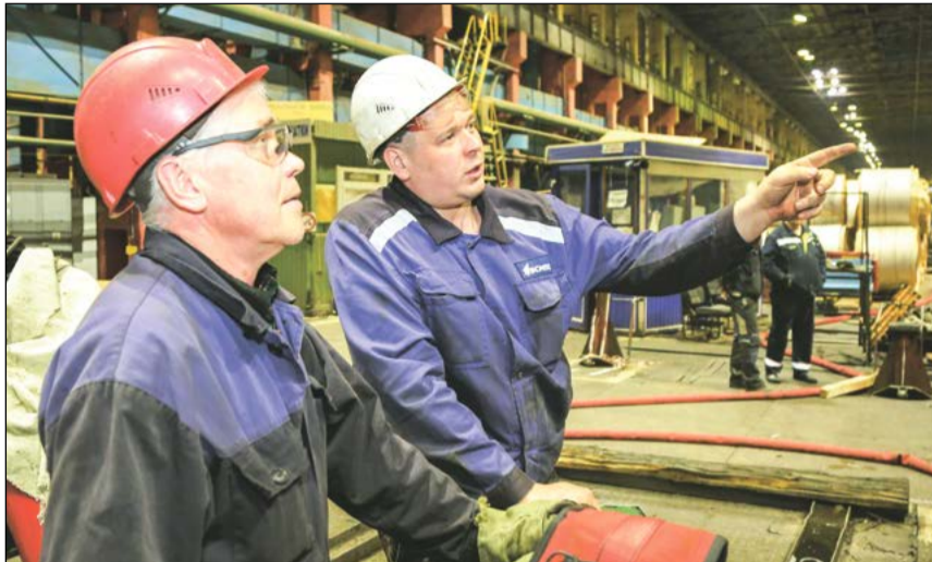
Слесари-ремонтники цеха № 50 рассказывают о сложностях монтажа
