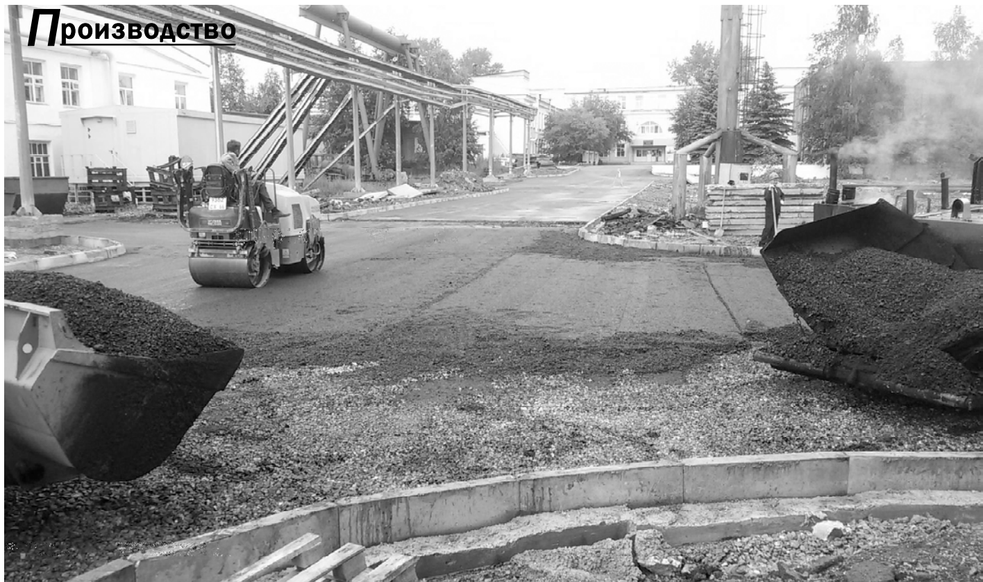
Реконструкция автомобильных дорог
