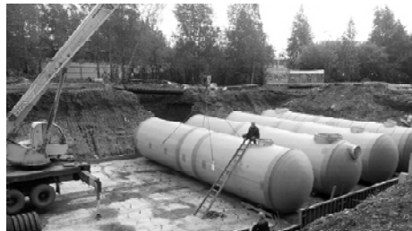
Реконструкция очистных сооружений
