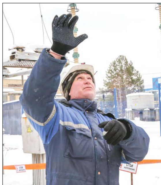
Мастер электромонтажников Сергей Климов руководит работами с земли
