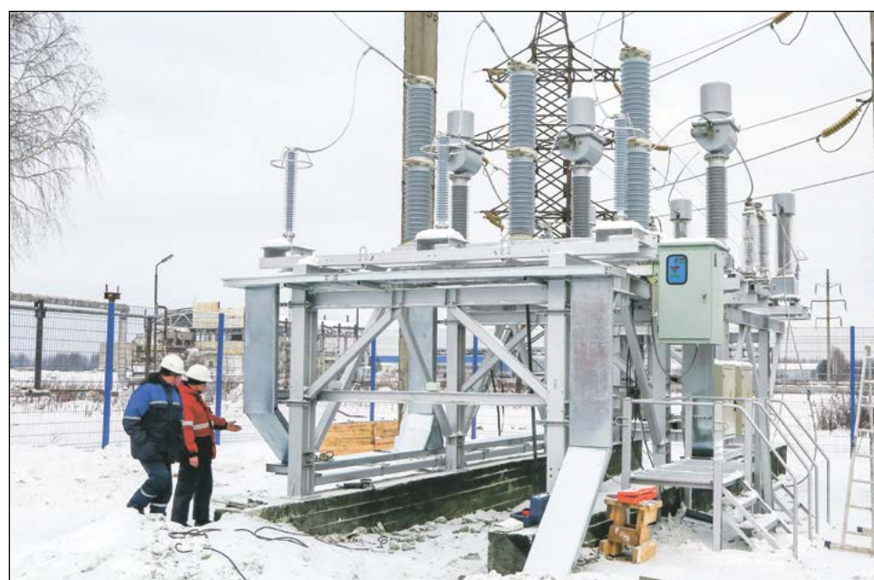
Новый блок-модуль смонтирован
