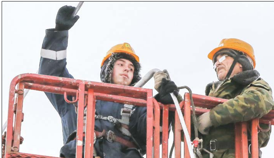
Электромонтёры Алексей Грибашев и Дмитрий Девятков подсоединяют ошиновку
