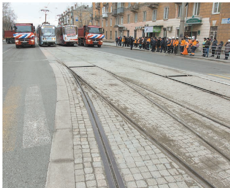
Открытие дороги на улице Космонавтов.
