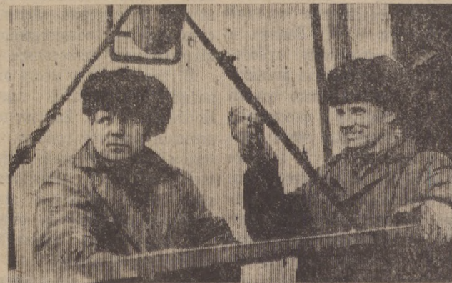
В. А. Кошечев и С. Д. Чурин (слева направо) ведут монтаж трубопровода и арматуры насосной завода комплектных металлоконструкций и нормы за два месяца выполнили в среднем на 140 процентов. Ударники коммунистического труда взяли повышенные обязательства к 110-й годовщине со дня рождения В. И. Ленина. Фото Е. Фролова.
