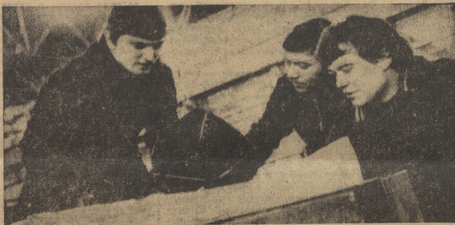
Девиз молодых рабочих завода трубчатых металлоконструкций Владимира Зубака, Виктора Зырянова, Павла Озорина (на снимке) — «60-летию Великого Октября — 60 ударных недель». На сборке металлоконструкций они перевыполняют нормы на 15—20 процентов.
