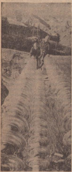
Монтаж изоляторов и подвеску проводов начали строители высокогорной ЛЭП-500, которая свяжет Токтогульскую ГЭС с городом Фрунзе. С вводом ее в строй действующих удвоится энергооборуженность промышленной и сельской хозяйства Северной Киргизии. Из Фрунзе новая ЛЭП шагнет в Казахстан. Двухсоткилометровая электромагистраль, пересекающая Тянь-Шань, пройдет через семь перевалов. 682 опоры высотой с девяти — и пятнадцатитиэтажные здания будут нести особо прочные провода.
