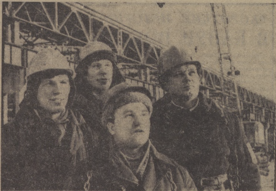
На снимке (слева направо): члены бригады Л. Н. Путьрского монтажники Н. Елисеев, Н. Мокроусов, Л. Путьрский, Н. Осипов.
