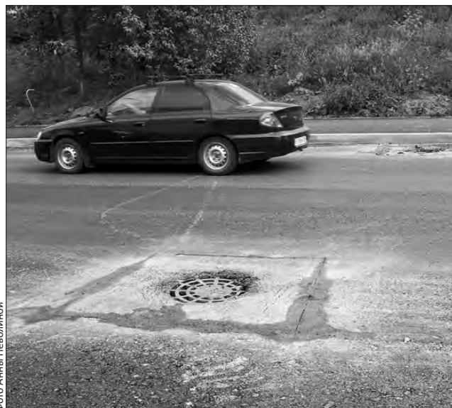
Сливной колодец сбрасывает воду в ливневую канализацию
