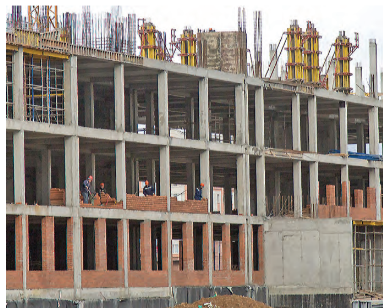
Возводятся наружные стены.
