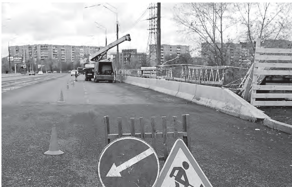
Мост на улице Космонавтов: проход запрещен, идет ремонт пешеходной зоны.
