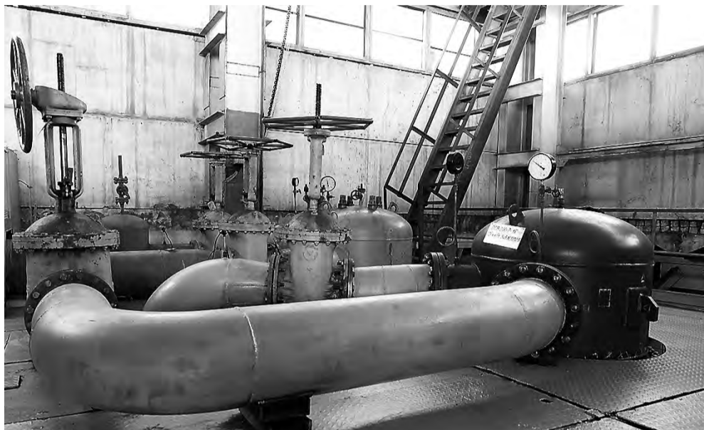
Подогреватель сетевой воды.
