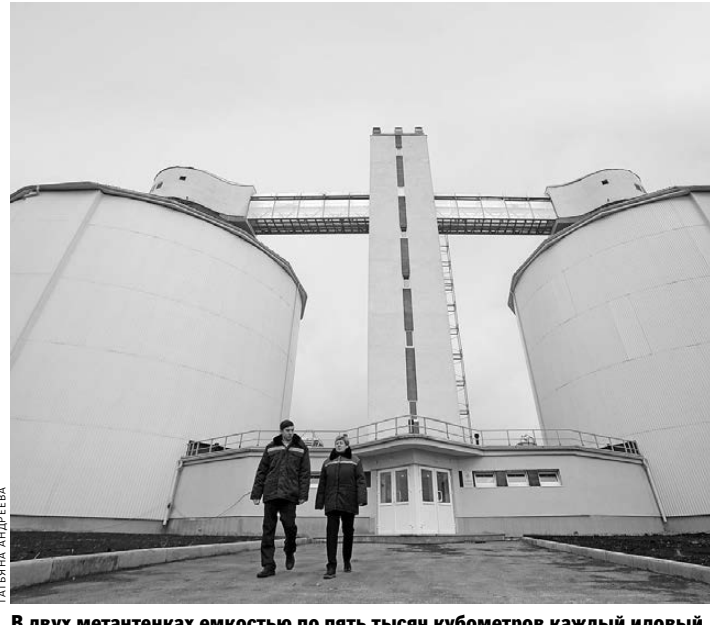
В двух метантенках емкостью по пять тысяч кубометров каждый иловый осадок сбрасывается для получения газа.
