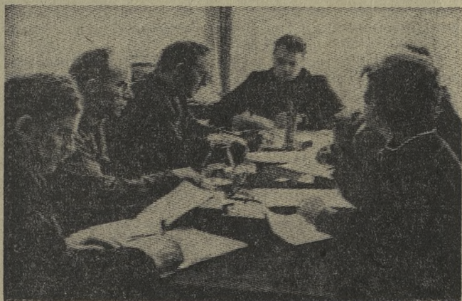
На реконструкции стана «140» № 3 Новотрубного завода создан партийный штаб, он руководит социалистическим соревнованием, воспитательной работой в коллективах строителей монтажников, работников цеха занятых на обновлении трубопрокатного агрегата. Его возглавляет секретарь цехового партбюро Н. А. Акимов.
