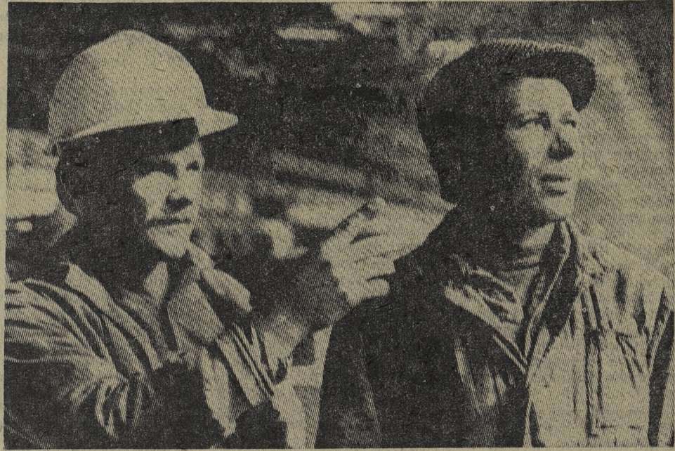
■ Капитальный ремонт стана «30-102» завершен
