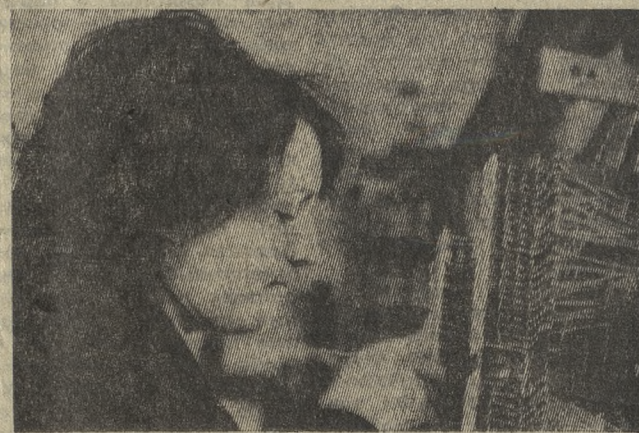
Оснащается всем необходимым новый корпус больницы Новотрубного завода, в том числе и внутренней связью. Монтаж АТС на 200 номеров ведет монтажники участка Востокпромсвязмонтаж Фина Кучукова.
