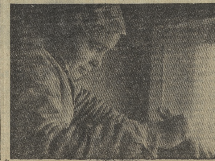
Мария Петровна Шпакова около пятнадцати лет работает на стройках города. За добросовестный труд ее, штукатура-маляра первого строительного управления, в прошлом году наградили Почетной грамотой. В своей бригаде Мария Петровна — инспектор по охране труда и технике безопасности. Женщина по-хозяйски относится к производству, увидит неполадки — сразу же сообщит в пост народного контроля. Дозорные считают Марию Петровну Шпакову своим активистом. Фото Н. БУЛЫГИНА.
