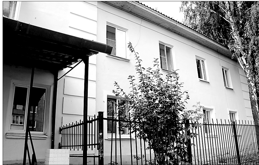
Два года назад внешний облик здания по улице Бажова, 21 преобразился – здесь сделали капитальный ремонт
