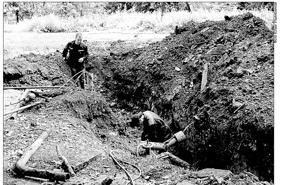
На улице Победы в любую погоду работает бригада из пяти человек, включая водителя экскаватора
