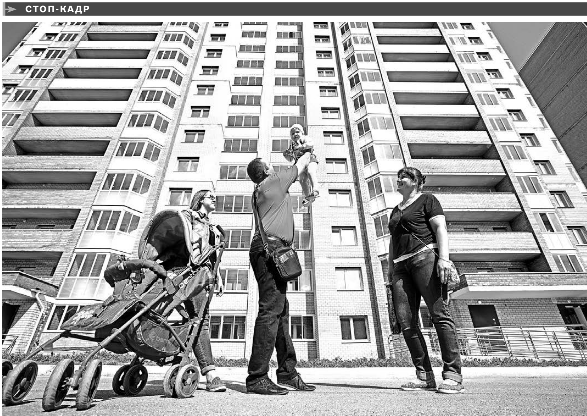
Семье Юнусовых из города-спутника Екатеринбурга Березовского вручили ключи от квартиры в одном из трех домов жилого комплекса «Березки». Вместе с ними новоселье справят еще 69 семей. Строительство ЖК началось в 2013 году. Первую многоэтажку сдали в срок. Квартиры во втором доме жильцы получили после трех лет ожидания, в третьем — более четырех. За шесть месяцев 2018 года в регионе решены проблемы 377 дольщиков, а с 2012 года жильем обеспечены свыше четырех тысяч уральцев, признанных пострадавшими от действий недобросовестных застройщиков.
