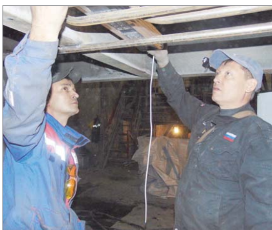
Электромонтёры Денис Березин и Михаил Чепурихин устанавливают освещение.
