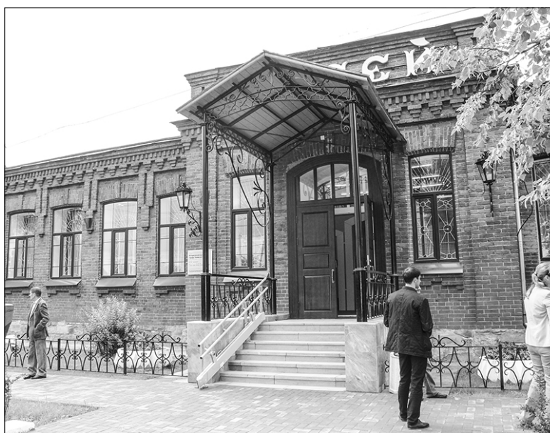
Сотрудники «РемСтройГрупп» провели реконструкцию внешнего вида исторического музея в Полевском, благоустроили его территорию
