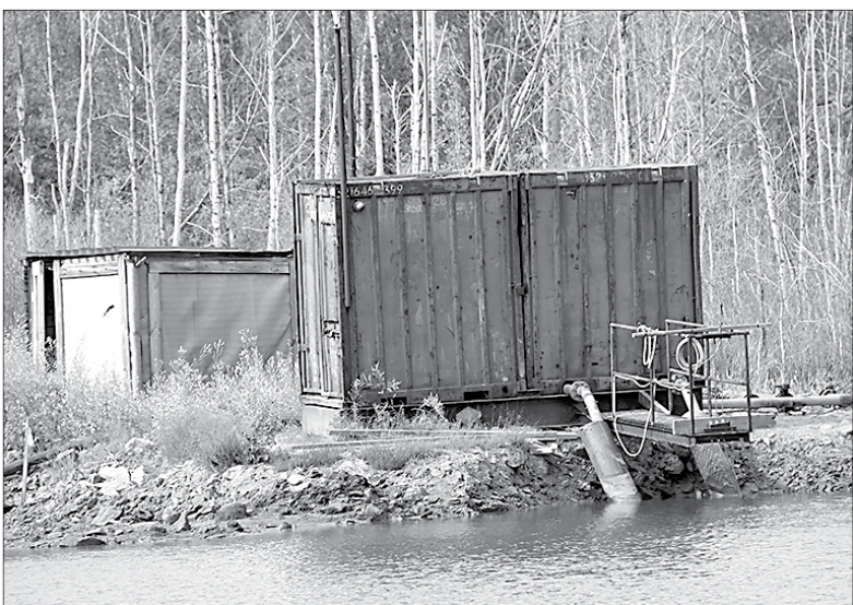
Узел нейтрализации, который построили в 2014 году, нейтрализует самоизливающиеся воды из южного провала шахты Гумешевского рудника
