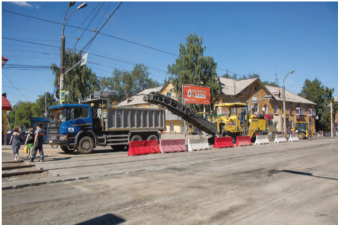
На перекрестке Красноармейской – Космонавтов снимают асфальт.
