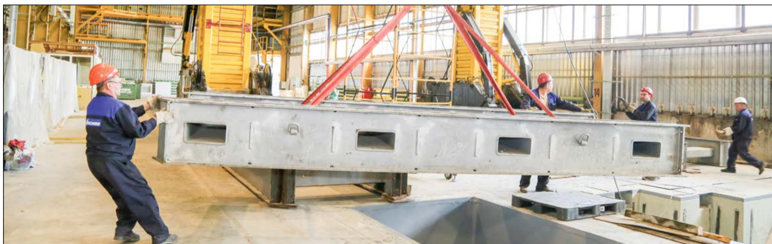
Слесари-ремонтники перекидывают звено рельсового пути портала
