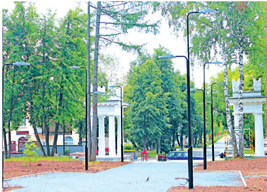
Сквер имени Ю.Гагарина. Установлены опоры наружного освещения.
