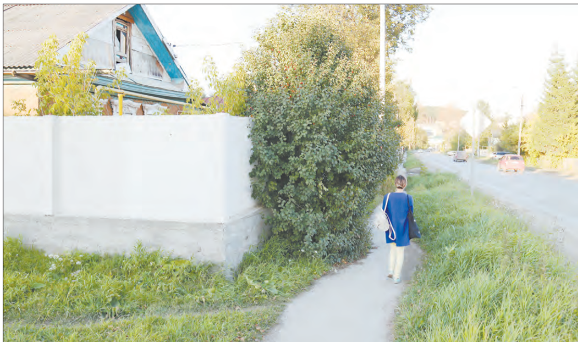
Этот забор и другие ограждения жителей по нечётной стороне ул. Ленина городская администрация посчитала самовольными постройками. И вынесла постановление о сносе
