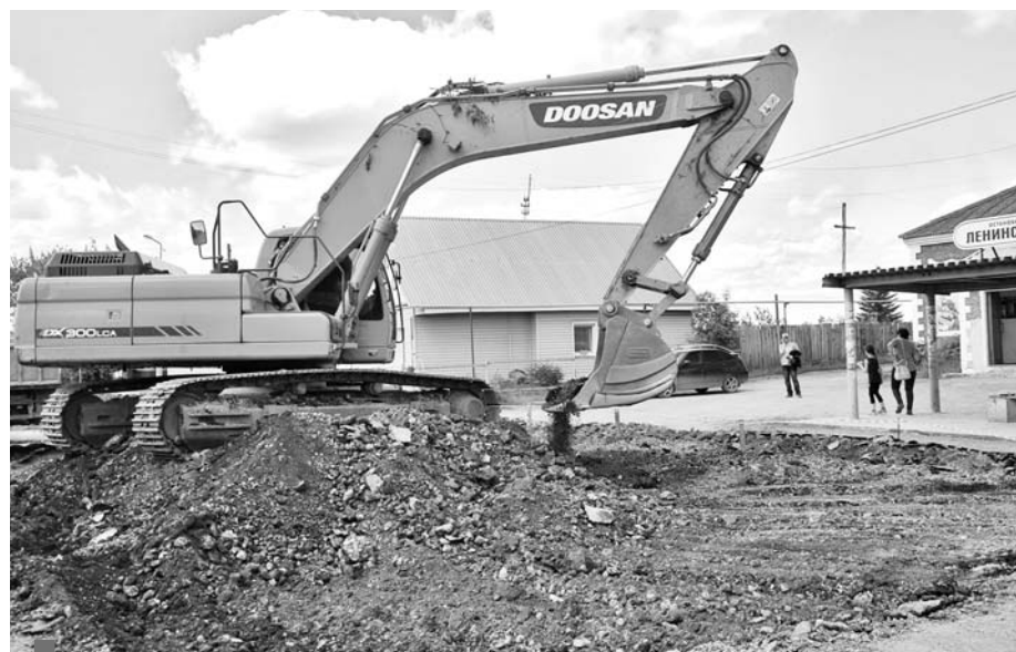
По улице Ленина снимают старое покрытие дороги
