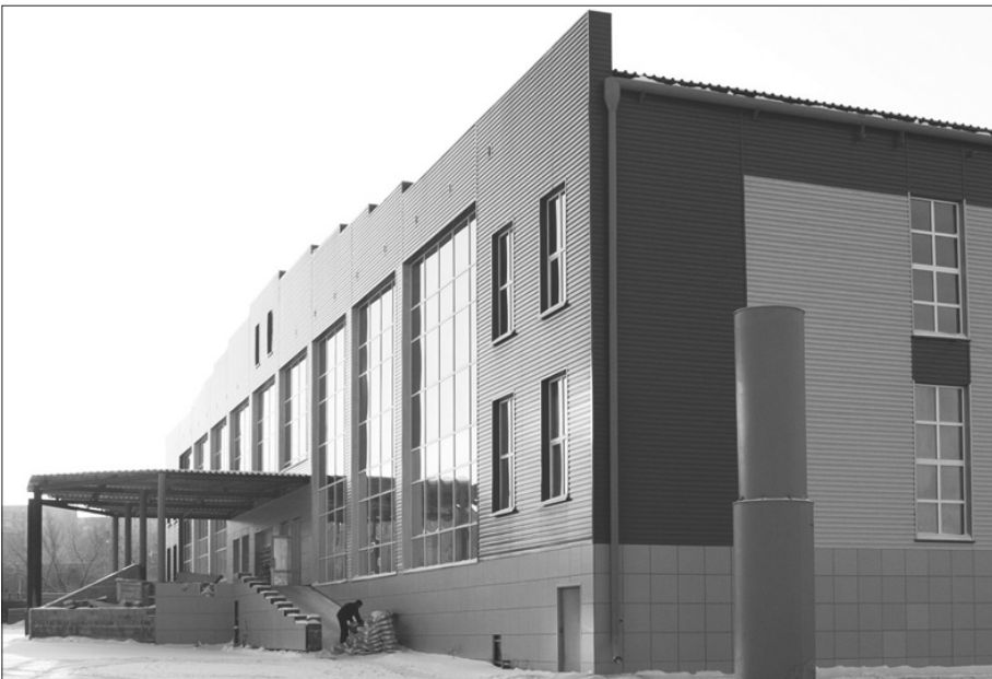
* Заканчивается строительство нового объекта.
