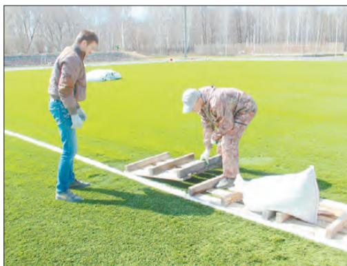
С помощью поддона и тяжелого мешка выравнивается склейка уложенной ленты разметки с газоном поля. Фото Николая Королева
