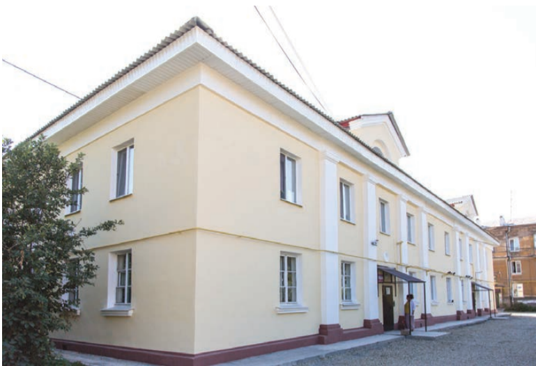
Дом №21 на Липовом тракте после капремонта.
